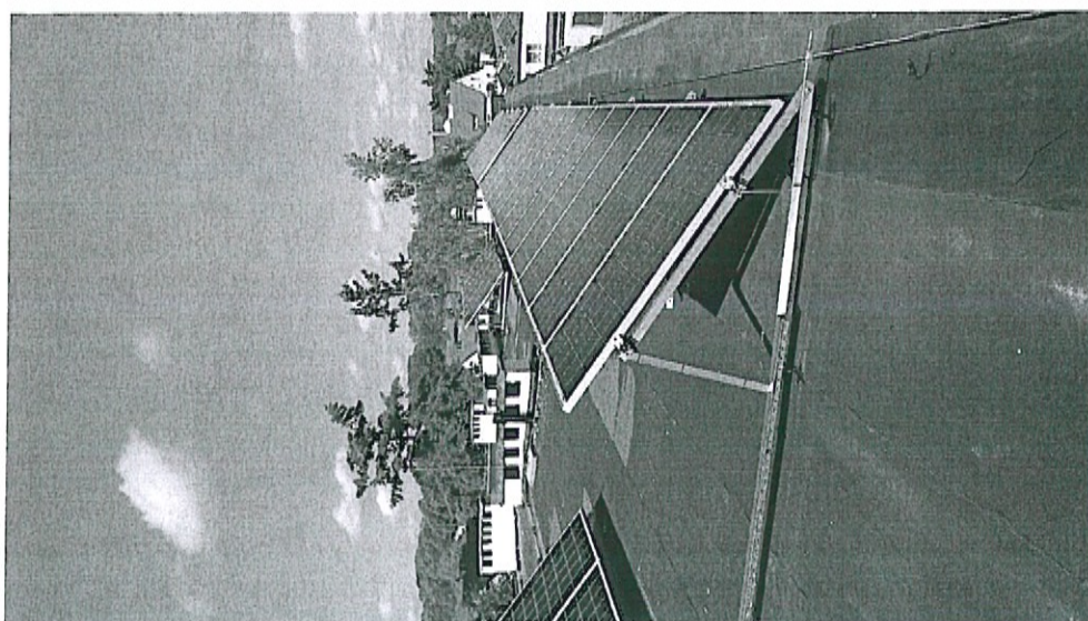
Przykładowa instalacja z ramą dla dachu płaskiego
